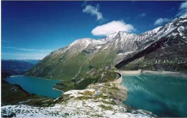
Bassin haut et bas de la STEP Limberg II, Australie. Source : Voith Hydro.
